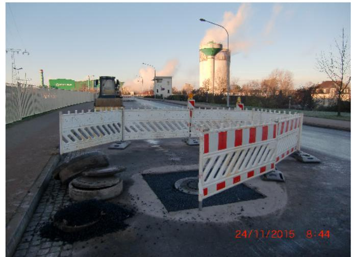
Bild 2 – Straßenschäden Heinrich-Schönberg-Straße    Bild 3 – Reparatur der Straßenschäden
